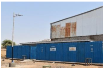
補修されたトイレ棟のひとつ。 左手前が安全灯
